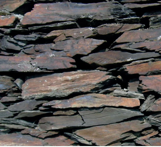
Abbildung 14: Bruchsteinmauerwerk aus Schiefer
