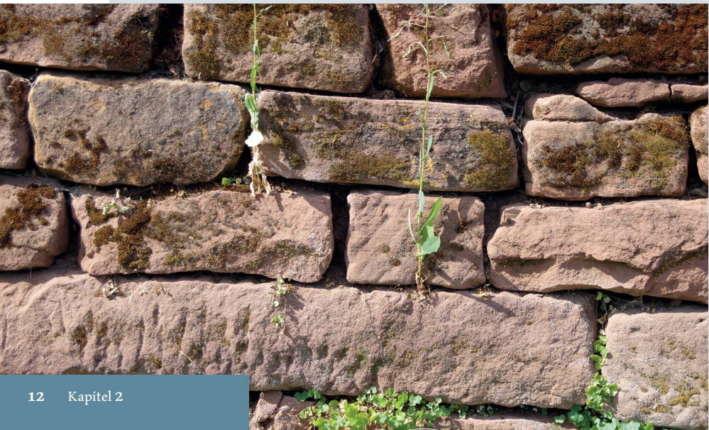
Abbildung 5: Trockenmauer aus Sandstein
