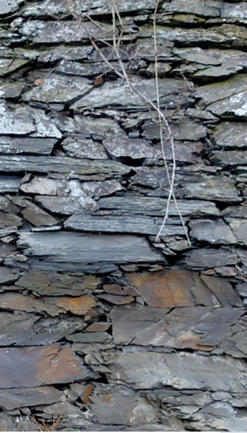
Abbildung 3: Trockenmauer aus Schieferbruchstein
