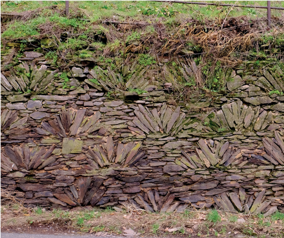
Abbildung 15: Bruchsteinmauerwerk mit Bogenelementen in Klüsserath an der Mosel
