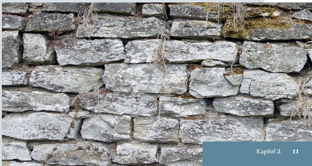
Abbildung 4: Trockenmauer aus Kalkstein
