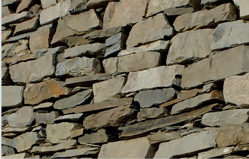
Abbildung 6: Trockenmauer aus Grauwacke
