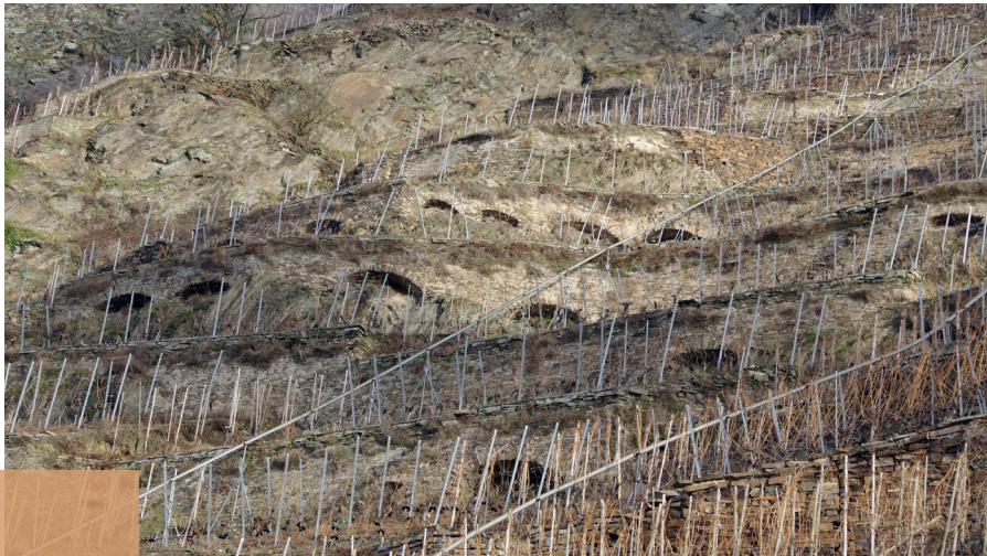
Abbildung 9: Die terrassierten Weinlagen des Winninger Hamm, des Winninger und Koberner Uhlen sind durch besonders zahlreiche Spannbögen gekennzeichnet.
