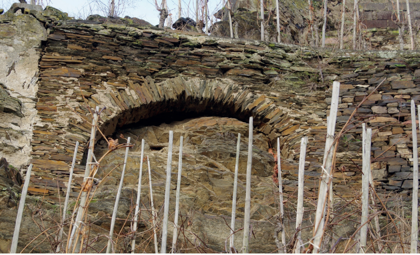
Abbildung 8: Spannbogen zur Überwindung vorspringender Felsformationen, Weinlage Winninger Hamm
